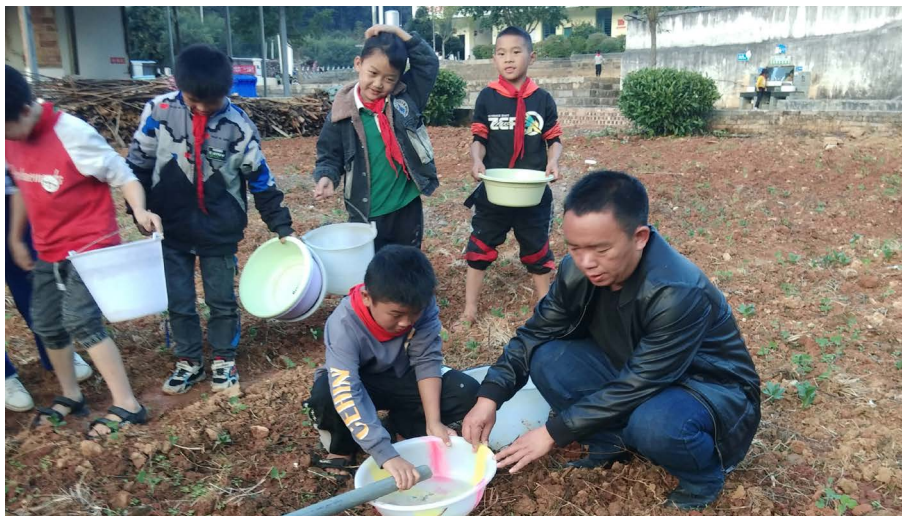
2022年11月，学校生活污水处理项目通过验收，正式投入使用。项目铺设和安装了水管，方便学校收集净化水，浇灌校内的花草树木和校园劳动基地里的蔬菜等。处理后的污水再次循环利用，节水和环保两不误，让设备发挥最大的长期效益
